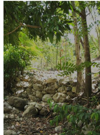
Delcius zeigt mir Steinschüttungen an den Hängen entlang des Flusses. Diese sind in den letzten Jahren fast überall entstanden und sollen bei Regen ein rasches Anschwellen des Flusses vermeiden und starke Überschwemmungen verhindern.
